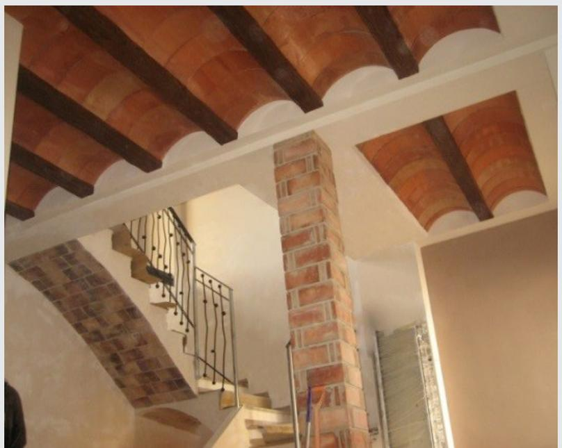
Figura 38 Obras con forjados cerámicos vistos inspirados en la arquitectura tradicional
