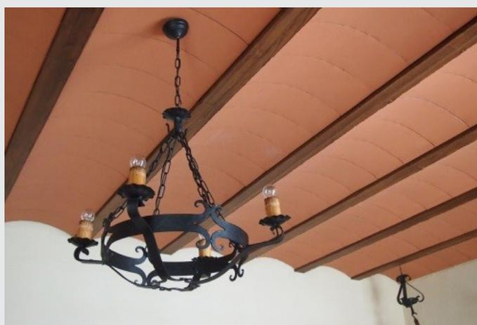
Figura 24 Posibilidad de colgar instalaciones en la bovedilla cerámico por su resistencia mecánica
