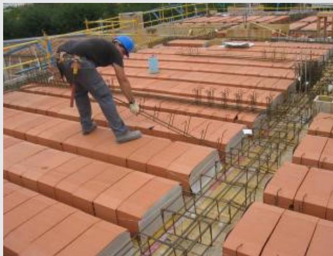
Figura 23 Seguridad en la puesta en obra por la elevada resistencia de la bovedilla cerámica
