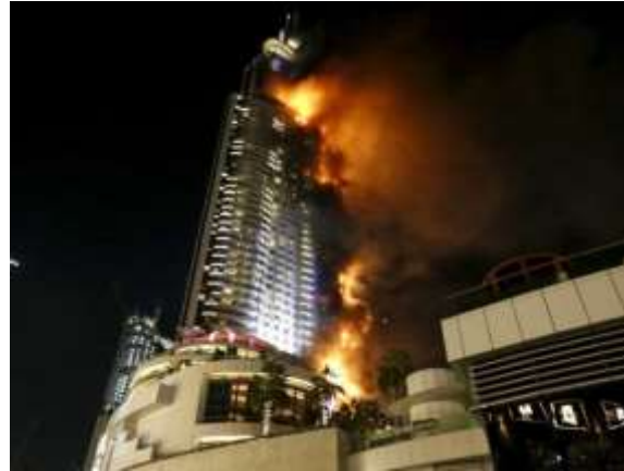
Edificio Saif Balhasa (12 plantas) 06/10/2012
