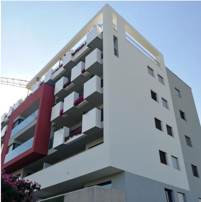
Figura 3. Fotografía de la fachada de un edificio con un sistema SATE
